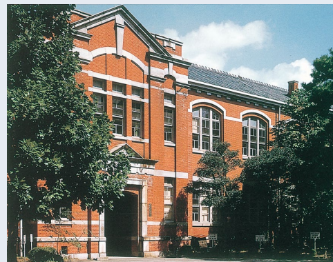
総合研究14号館(旧 工学部 土木工学教室本館)
