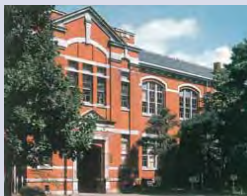
工学部 土木工学本館
