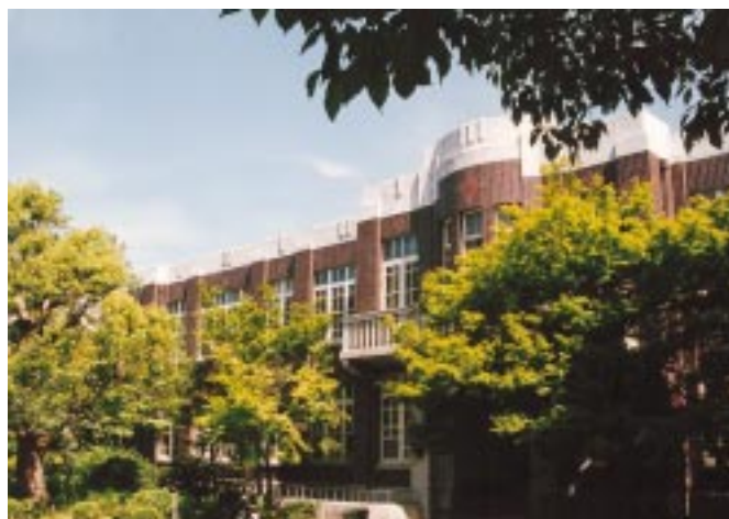
(建築学教室本館)
