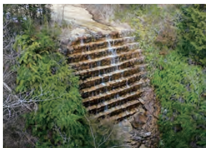
堂山山中の谷に明治期に造られた錨堰堤 (写真2)
